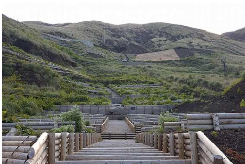
三宅島金曽沢地区で施工後（せこうご） 数年経過（けいか）した、緑化が進んでいる写真
