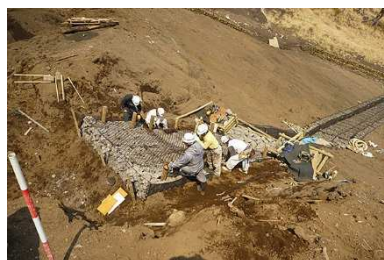
三宅島金曽沢地区での治山復旧工事の写真
