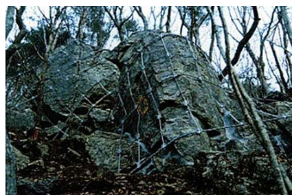
落石予防工（固定工）
