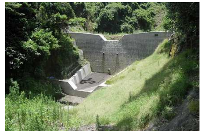
泉津沢【2】復旧状況
