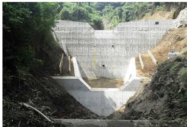
泉津沢【2】工事完了
