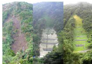
伊豆大島台風26号災害 [平成25年（2013年）発生]
