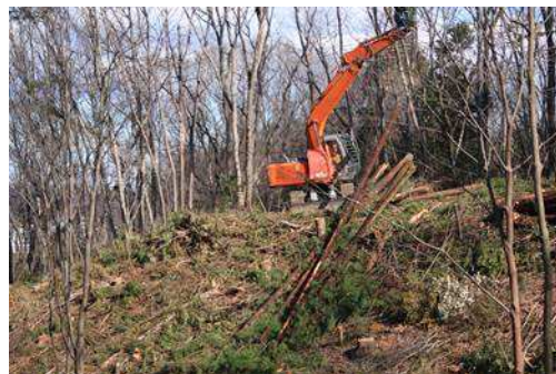
材をワイヤーに固定後、無線で合図し集材します
