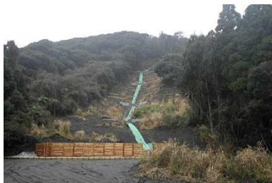
不重工事完了の写真不重 工事完了
