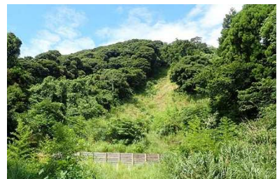
不重復旧状況の写真不重 復旧状況
