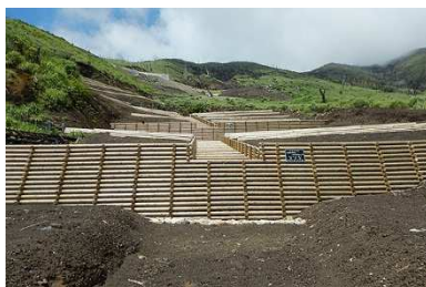
三宅島金曽沢地区での施工完了直後の写真
