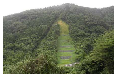
泉津沢【1】復旧状況
