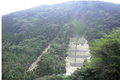
泉津沢【1】工事完了 (かんりょう)
